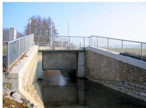
Konstruktion: Bauart TESACO, nach DIN 19569-4, 4-seitig dichtend, 6 mWS auf VS/RS
